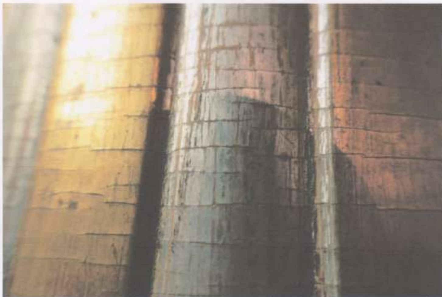
43. Trzon kolumny. Strona prawa. Odkrywka na srebrzonych kanelach. Widoczne ślady zielonego laku na srebrze.
