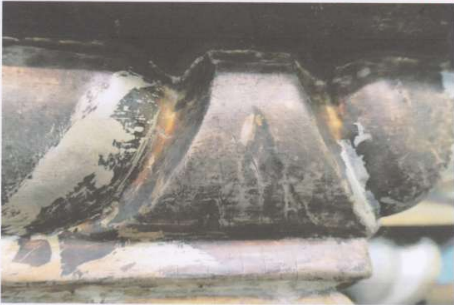
44. Trzon kolumny. Strona prawa. Odkrywka na zloceniach. Widoczne ślady zielonego laku na srebrze, pod warstwą szlagmetal.
