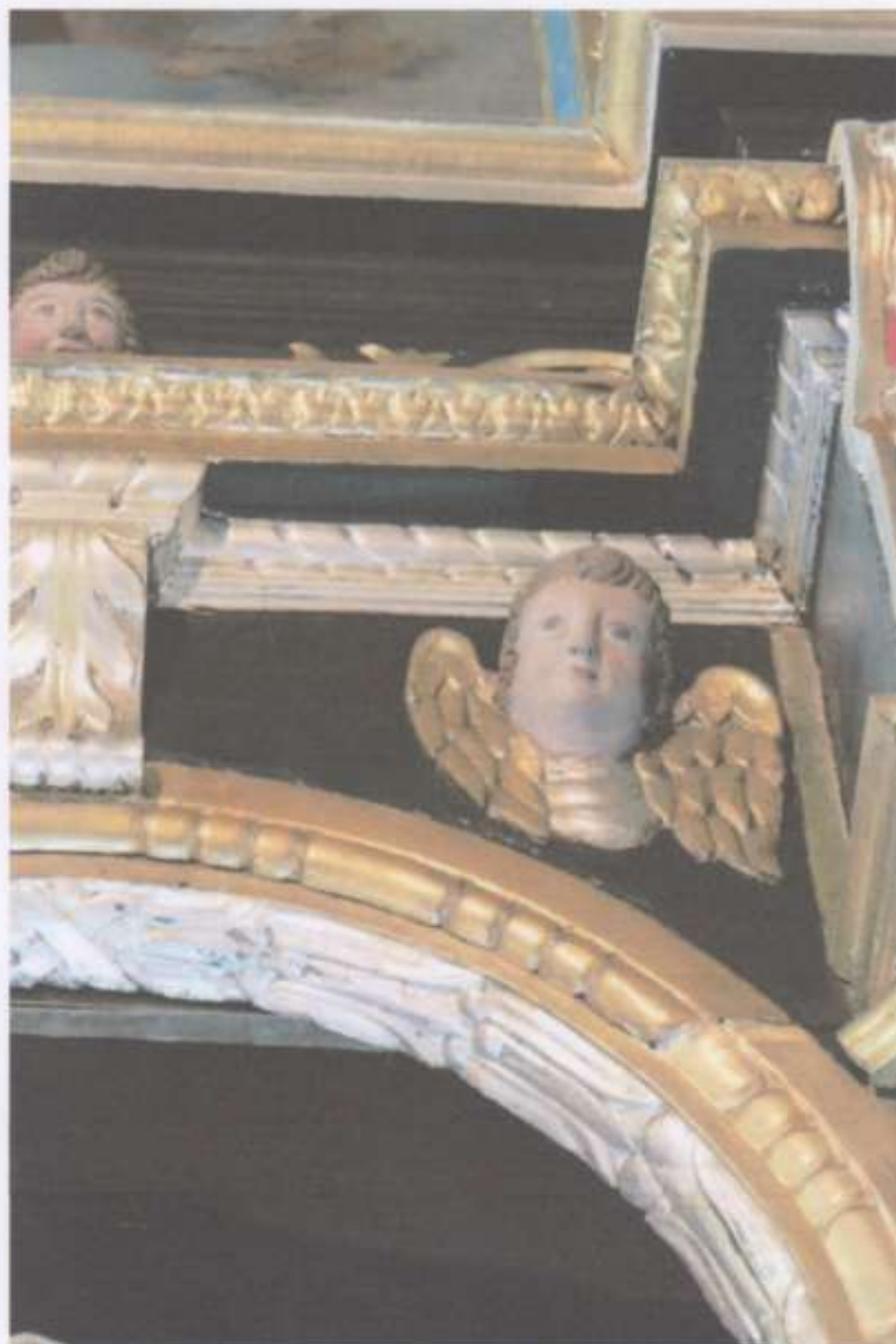
11. Putto z prawej strony niszy centralnej. Widoczne pęknięcia ramy głównej.
