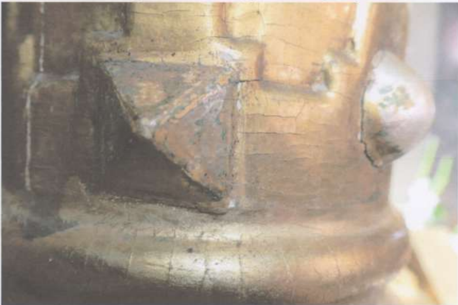
39. Trzon kolumny. Strona prawa. Odkrywka na zloceniach. Widoczne ślady zielonego laku na srebrze, pod warstwą szlagmetal.
