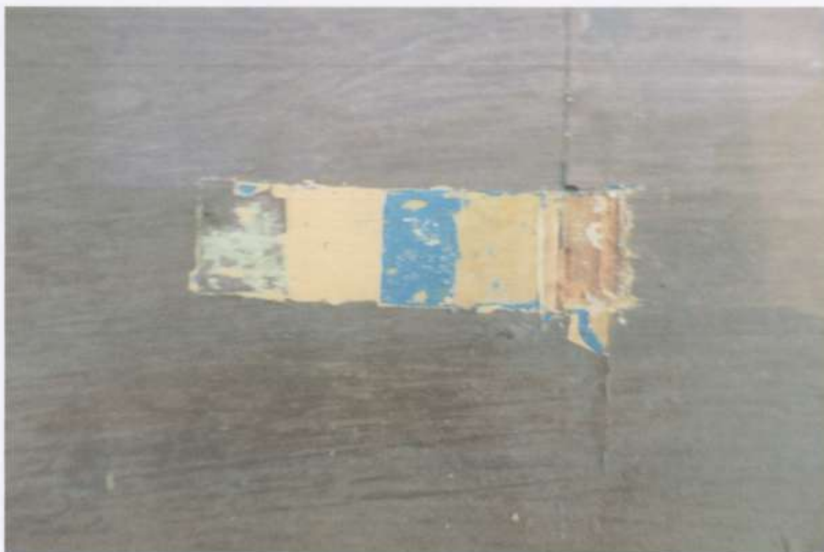
18. Odkrywka stratygraficzna na bramce obejścia. Strona prawa.
