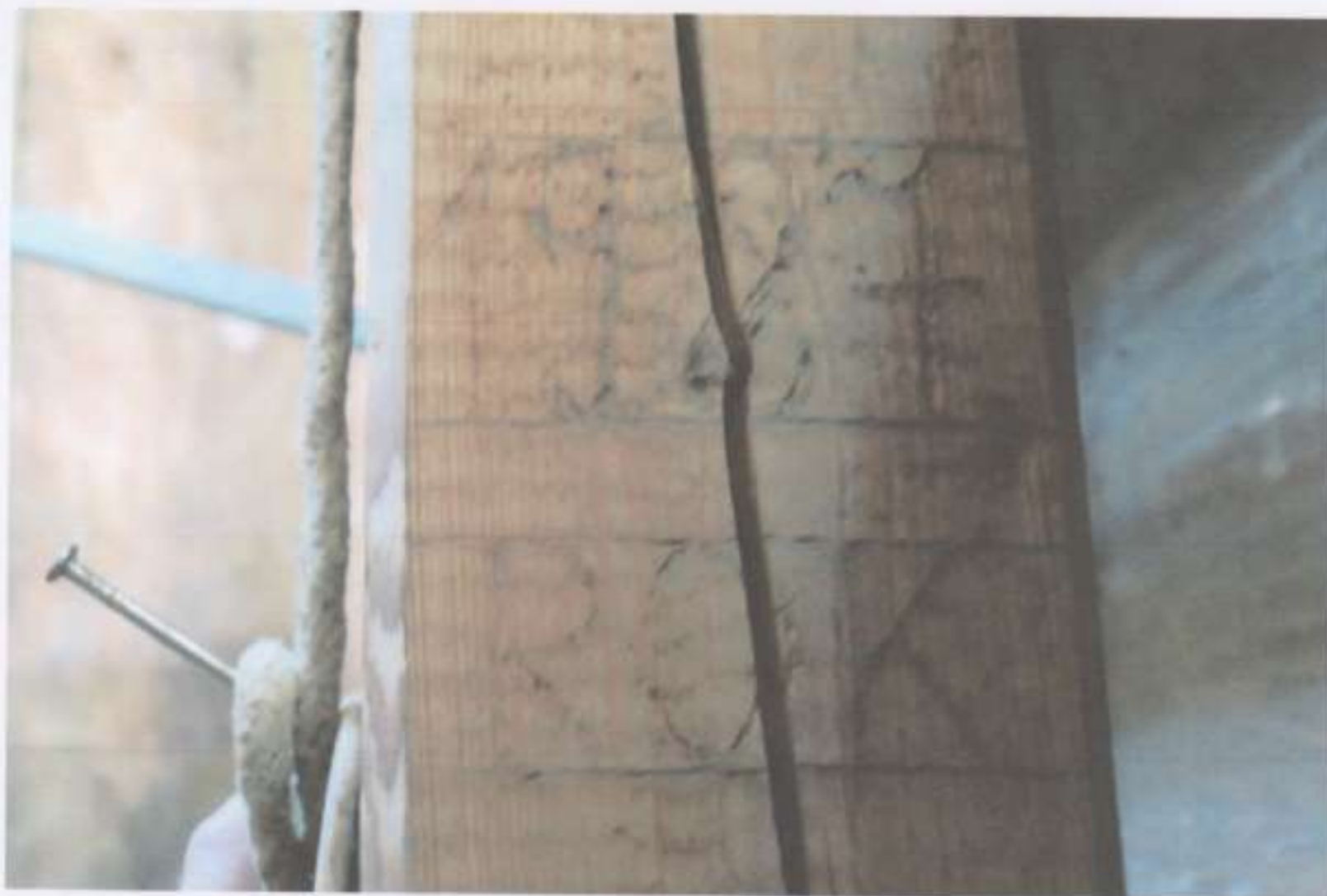
22. Odwrocie ołtarza. Konstrukcja nośna. Widoczna data 1987.
