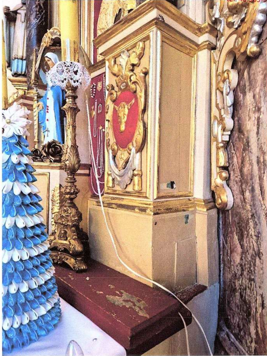
6. Część cokołowa- miejsce wykonania odkrywek
