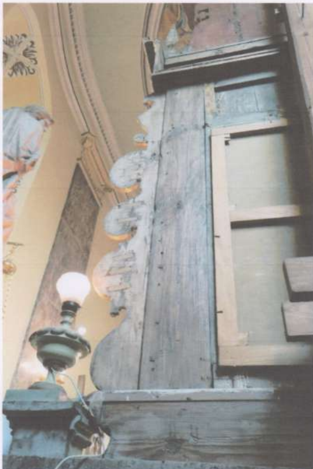
20. Odwrocie ołtarza. Strona prawa. Widoczne reperacje stolarskie na uszaku. Widoczny nowy blejtram obrazu.
