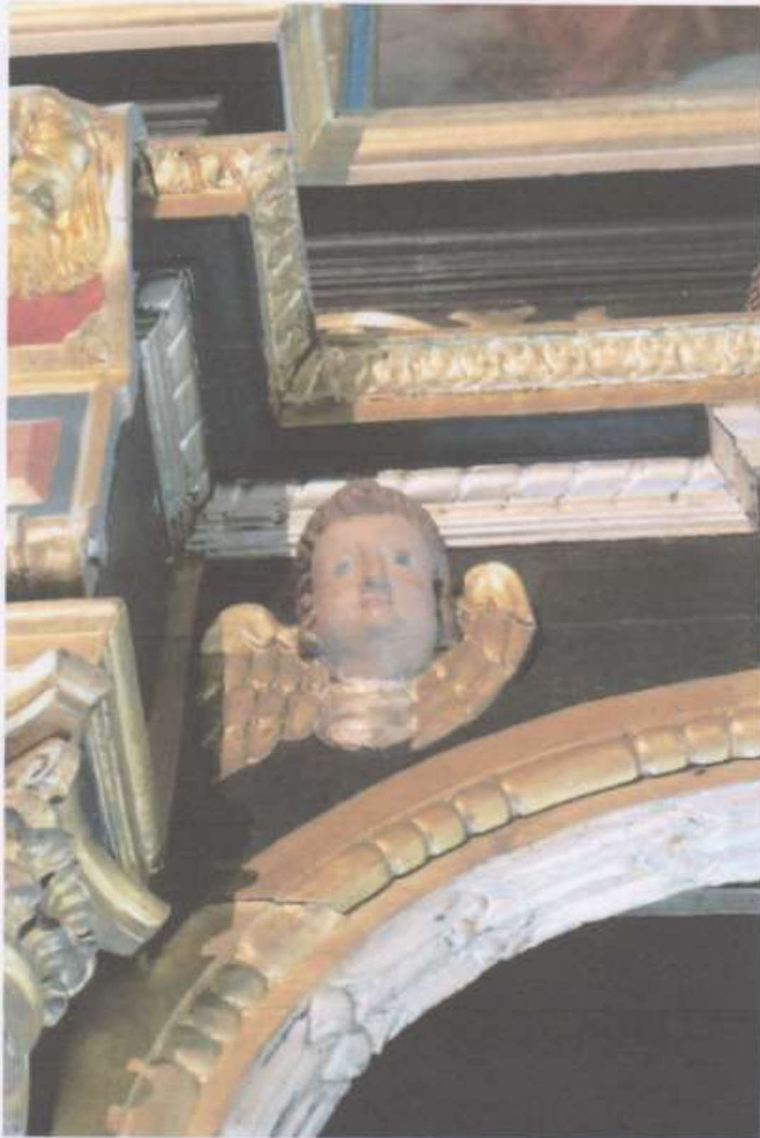
10. Putto z prawej strony niszy centralnej. Widoczne pęknięcia ramy głównej.
