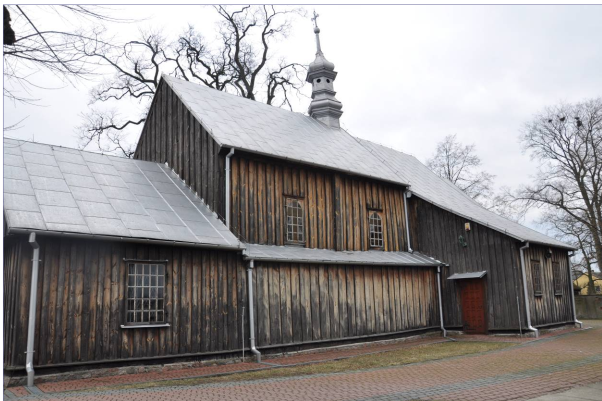
elewacja zachodnia z głównymi drzwiami wejściowymi i krucyfiksem - zawilgocenie i omszenie podwaliny i okapu nad nią, wypłukanie warstw ochronnych powodujące wypłowienie i osłabienie desek szalunku, zróżnicowana kolorystyka desek szalunku elewacji oraz stolarki drzwi
