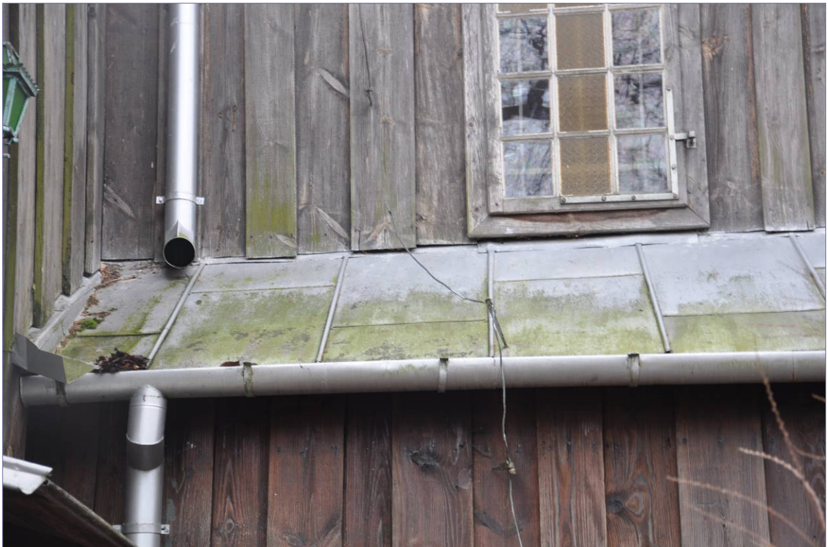
fragment elewacji kościoła , znaczne zawilgocenie i omszenie podwaliny i okapu nad nią, wypłukanie warstw ochronnych drewna powodujące wypłowienie i osłabienie desek szalunku oraz ram okna; spękane z ubytkami kity szklarskie
