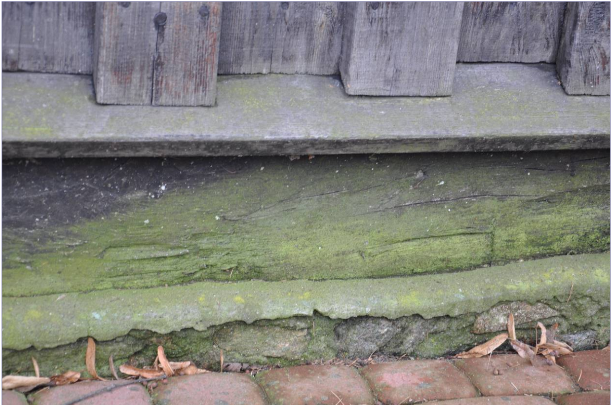
fragment elewacji kościoła , znaczne zawilgocenie i omszenie podwaliny i okapu nad nią, wypłukanie warstw ochronnych drewna powodujące wypłowienie i osłabienie desek szalunku oraz ram okna; spękane z ubytkami kity szklarskie
