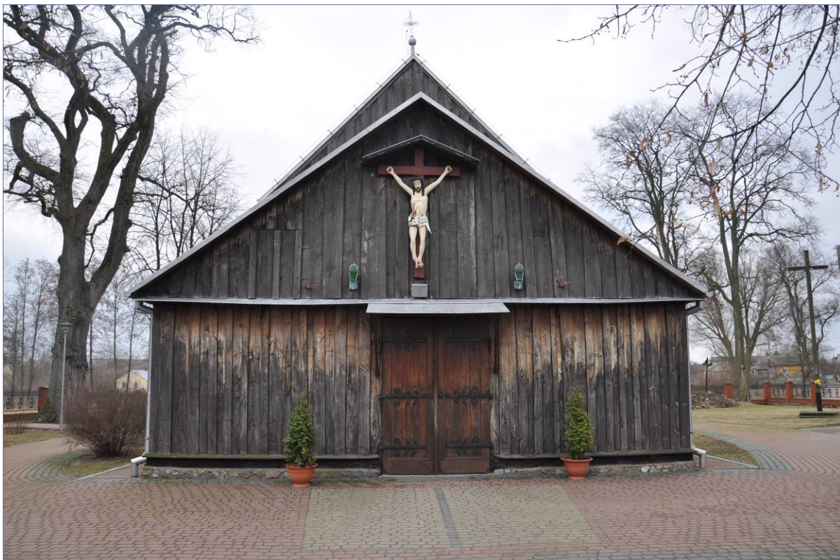
elewacja zachodnia z głównymi drzwiami wejściowymi i krucyfiksem - zawilgocenie i omszenie podwaliny i okapu nad nią, wypłukanie warstw ochronnych powodujące wypłowienie i osłabienie desek szalunku, zróżnicowana kolorystyka desek szalunku elewacji oraz stolarki drzwi
