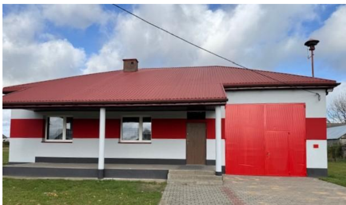
Budynek Ochotniczej Straży Pożarnej w Kadłubskiej
